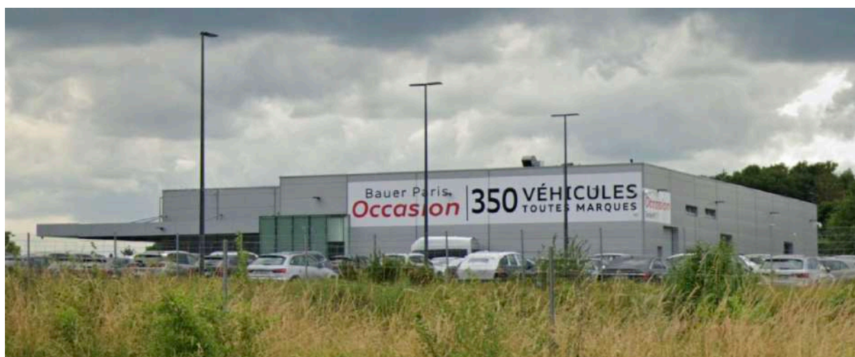
Exemple d'enseigne pour lequel le format excède la surface autorisée, Saint-Witz, octobre 2023.
